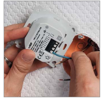
Bild 4: Vor dem Anschluss des ❷ HomeMatic Funk-Rollladenaktors sollte die Seriennummer notiert werden, da diese für den Anlernvorgang erforderlich ist. Danach kann der Aktor verdrahtet werden.
