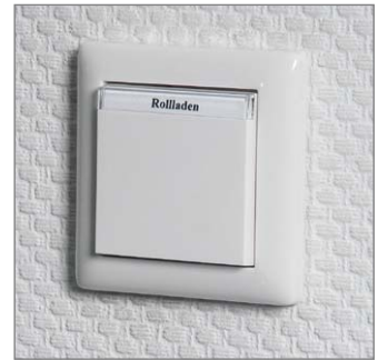
Bild 8: Nach erfolgter Montage kann der Stromkreis wieder eingeschaltet und der HomeMatic Funk-Rollladenaktor durch Eingabe der Seriennummer an der ❶ HomeMatic Zentrale CCU2 angelernt werden.
