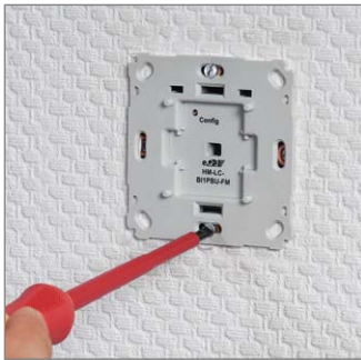
Bild 5: Der Aktor wird mit den beiliegenden Geräteschrauben in der UP-Dose fixiert.
